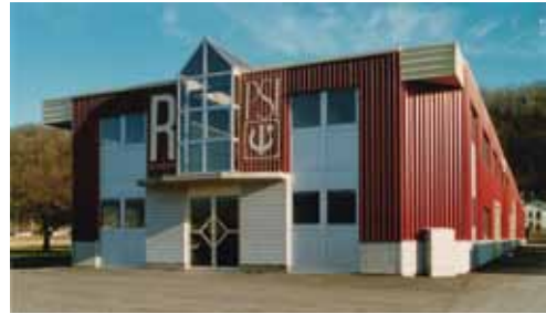
Das Firmengebäude in Yverdon / Schweiz
